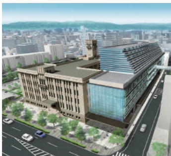
▲2025年3月に完成予定の中京区・市役所北庁舎(右)
